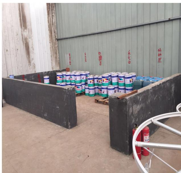
图 6-8 油漆存储区围堰
