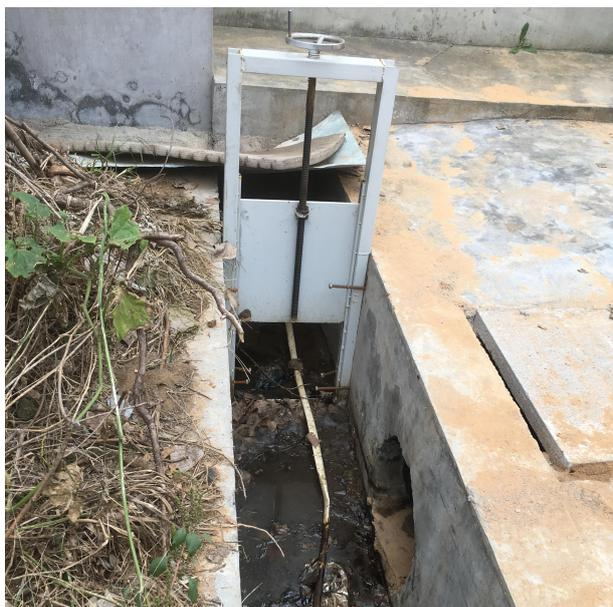
图 6-4 雨水总排口截止阀
